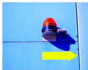
Exterior de cocheras
