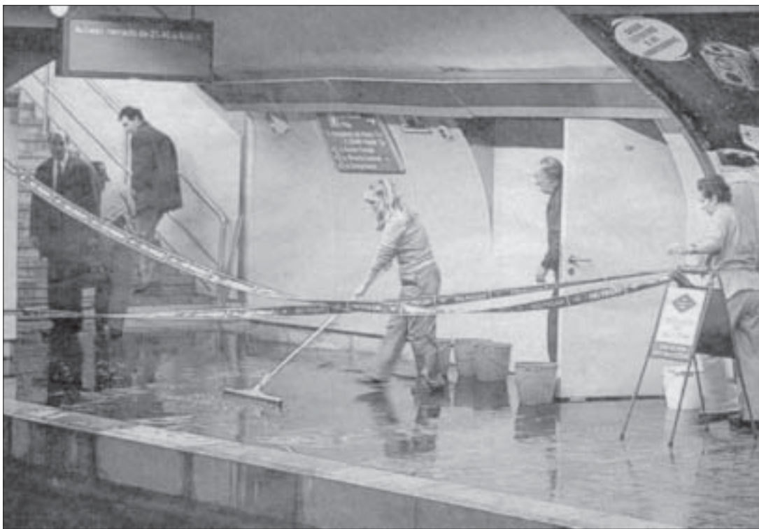
Gran filtración en la estación de Pueblo Nuevo.
