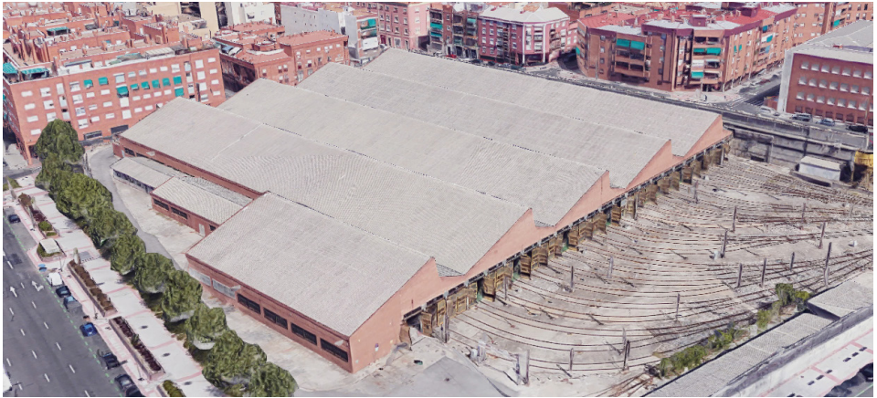
Depósito de Castilla fue demolido en 2016, hasta entonces mantuvo las cubiertas de fibrocemento.
