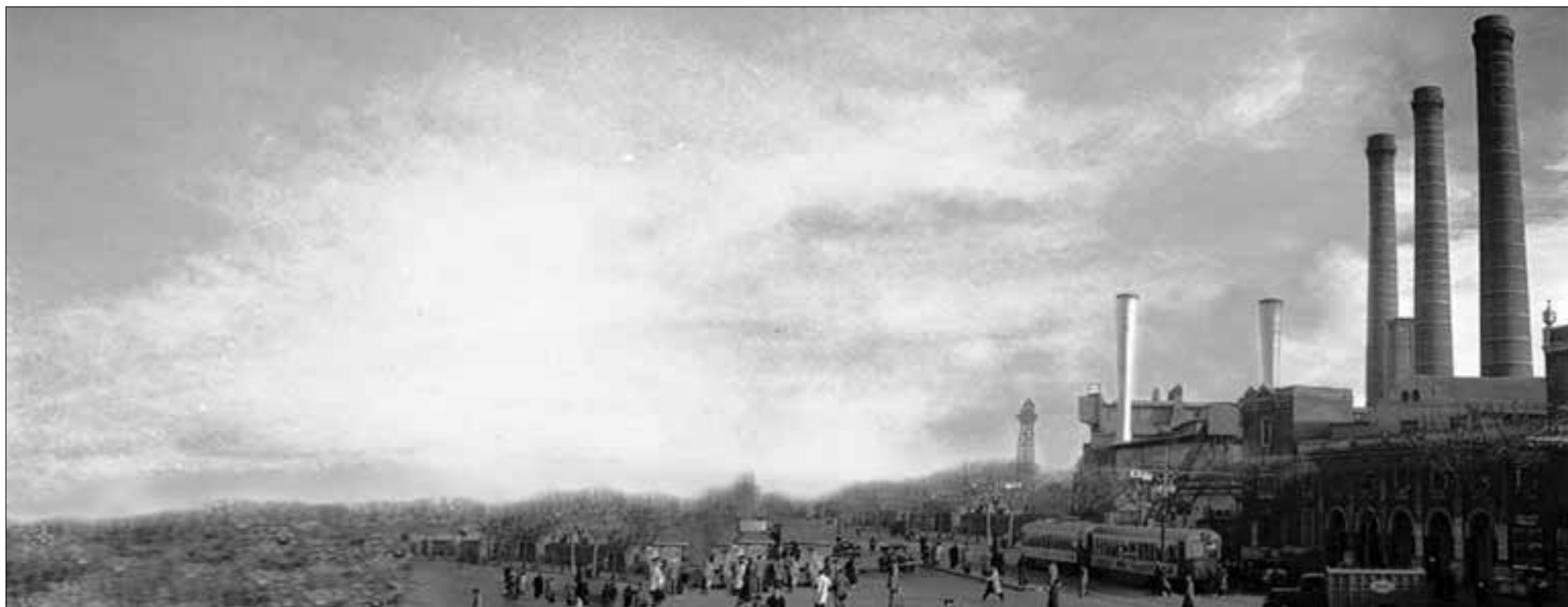
Las tres chimeneas, distintivo de la Sede Central de La Canadiense (Canadenca) en el Paral-lel de Barcelona
