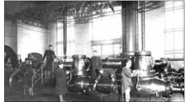
Repercusiones en las empresas del agua. En la foto ingenieros militares trabajan en la sala de máquinas de la Compañía de Aguas de Cornellá.
