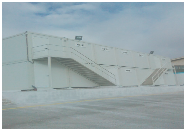
Vestuario, Oficina Capataces y Almacén
