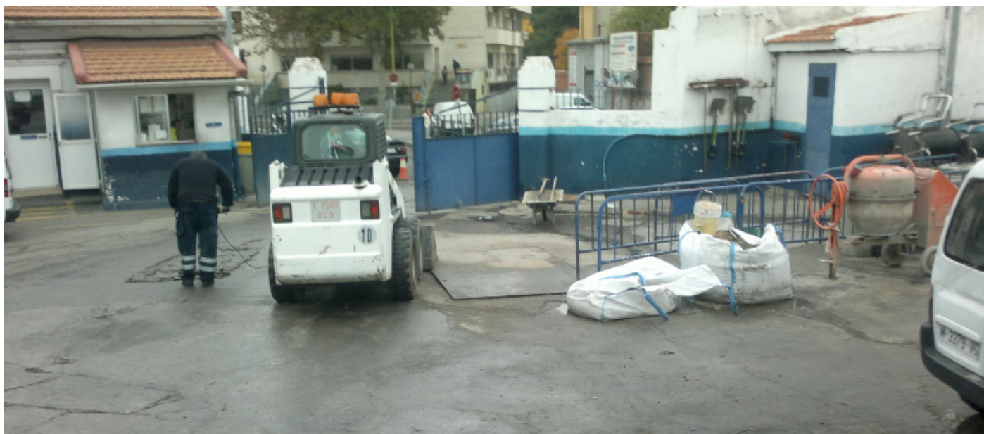
Obras en el patio de María Odiaga
