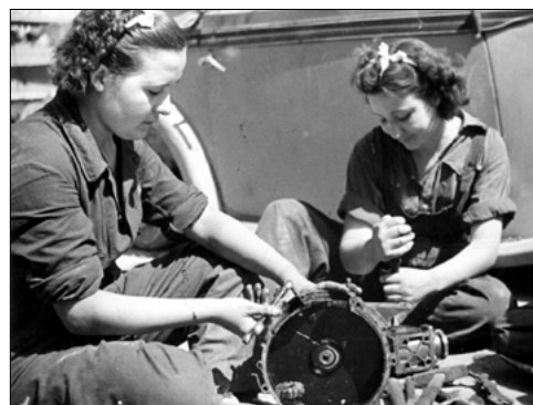
Desmontando un motor de combustión interna
